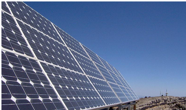
Fig. 128 - Panou solar tipic
