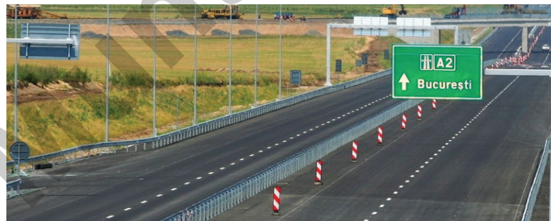
Autostrada 2 - București - Constanța
