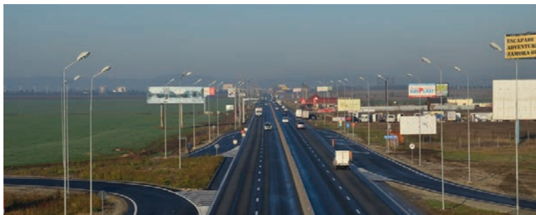
Drumul Județean de centură 236 - zona de nord Ploiești
