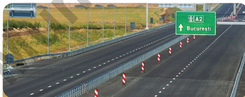
Autostrada 2 - București - Constanța
